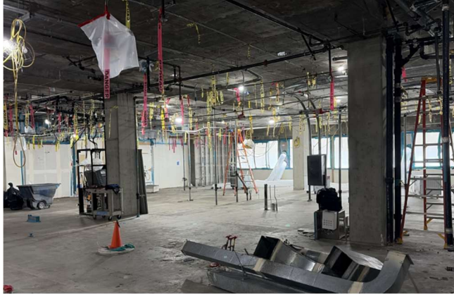
5E Demolition and Abatement
